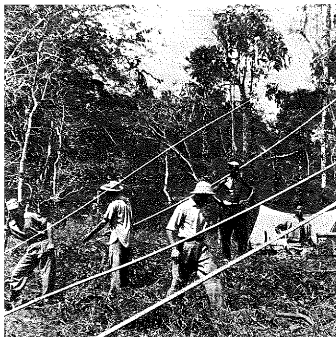
Brasile. Cantiere di tesatura sulla linea Santa Lucia (1952). Sotto: la prima linea completata dalla SBE: Santa Lucia-Belo Horizonte.
