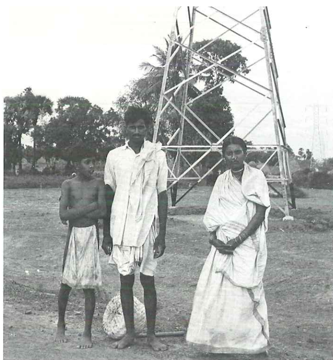
India: 1952. Foto ricordo davanti al primo palo del Mackhund Project. A destra, in alto: smontaggio linea 132 kV Vijoyavada Rajahmundry. Sotto: linea contatto ferroviaria 3000 v c.c. Calcutta e suburbi.
