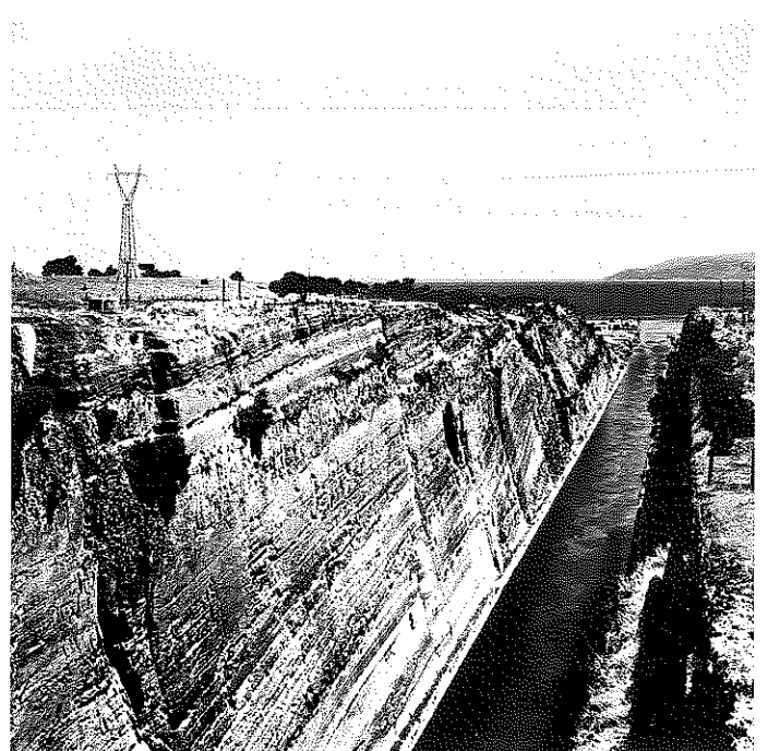
Grecia. Attraversamento 150 kV dell'Istmo di Corinto.
