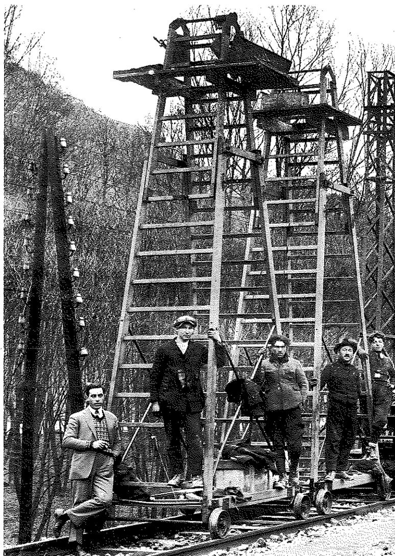
Carrelli semoventi con piattaforma di lavoro utilizzati durante l'elettrificazione della «storica» linea della SAE Bolzano-Brennero.
